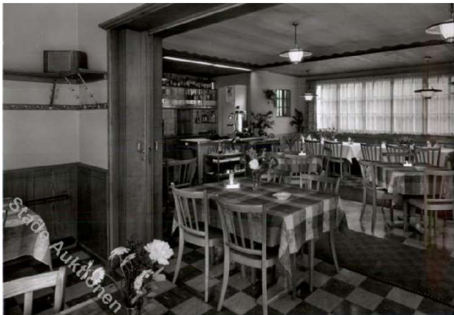
Ehem. Hotel-Rest. Anker, Signalstr. 15, 9401 Rorschach
