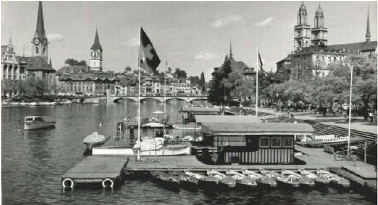
Bootsplattformen, beim Limmatquai, 8001 Zürich (1956)
